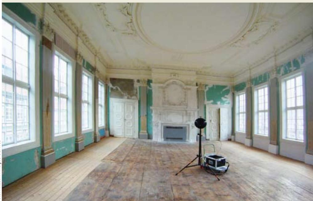
**Schalleintrag minimieren.** Die Verbesserung des Schallschutzes ist in Absprache mit dem Denkmalschutz am ehesten über die großen Fensterflächen möglich.
