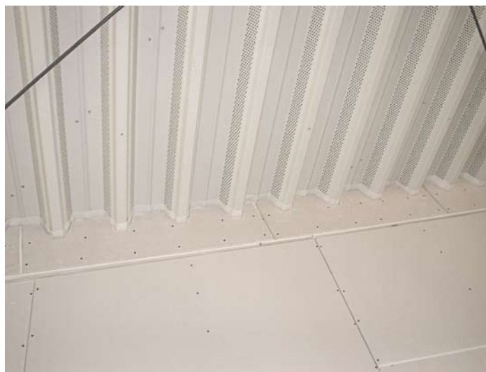
Flanken dicht. Die luftdichte Anarbeitung des gleitenden Deckenanschlusses in Verbindung mit einer konstruktiven Trennung der durchlaufenden Trapezbleche innerhalb der Schallschotte half, die Flankenübertragung zu verhindern.
